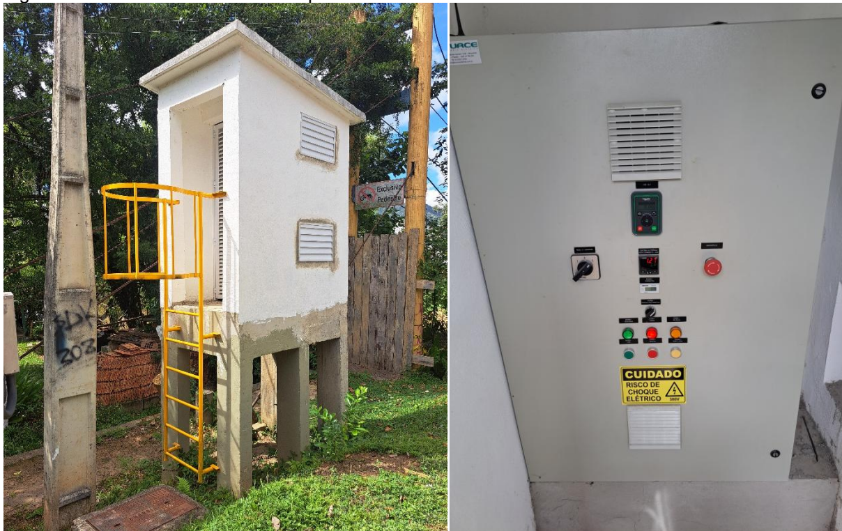
Figura 66: Elevatória EE-E3- 5 CV – painel de comando – 03/2025 -
