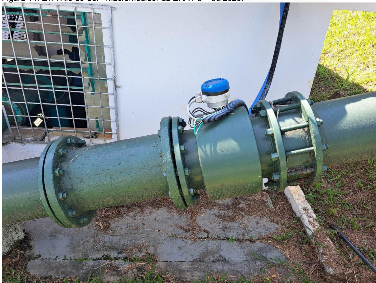
Figura 44: ETA Rio do Sul - macromedidor da ERAT 3 – 03/2025.
