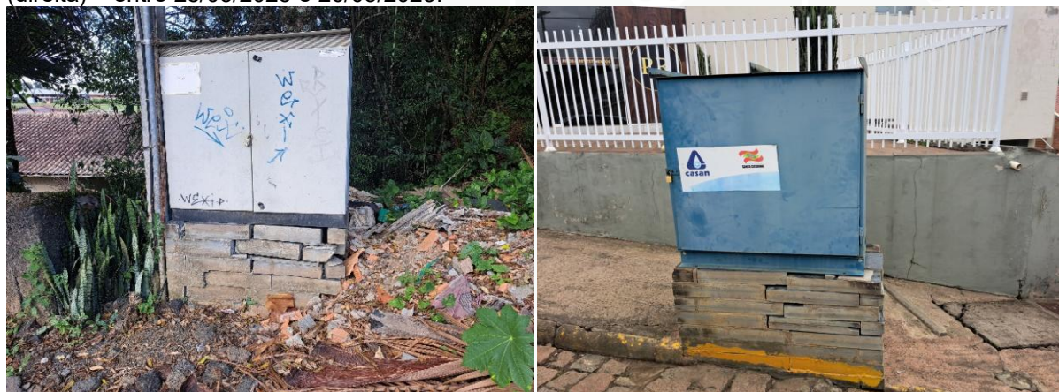
Figura 59: Problemas nas bases construídas com blocos de rocha - Booster 9 (esquerda) e booster 75 (direita) – entre 25/03/2025 e 26/03/2025.
