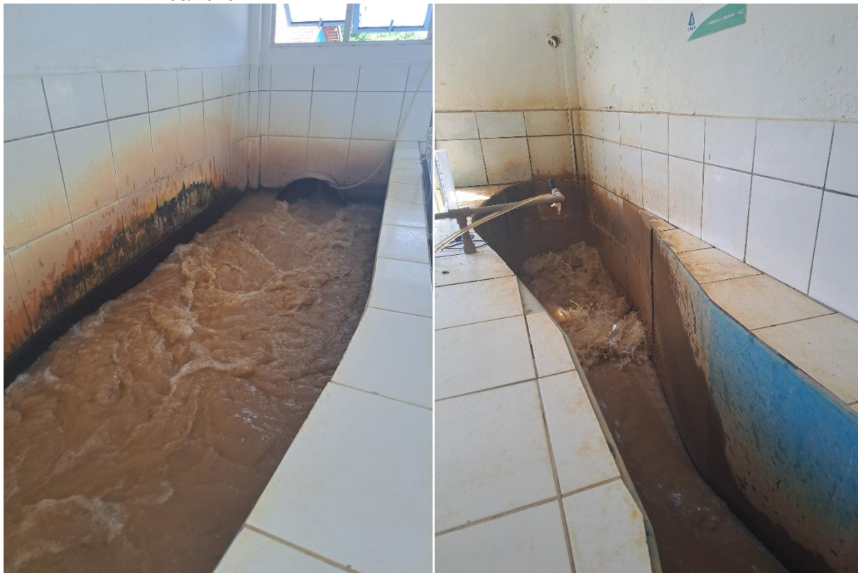
Figura 36: ETA Rio do Sul - Canal de entrada – Calha Parshall e dosagem de coagulante - ETA de concreto armado – 03/2025.
