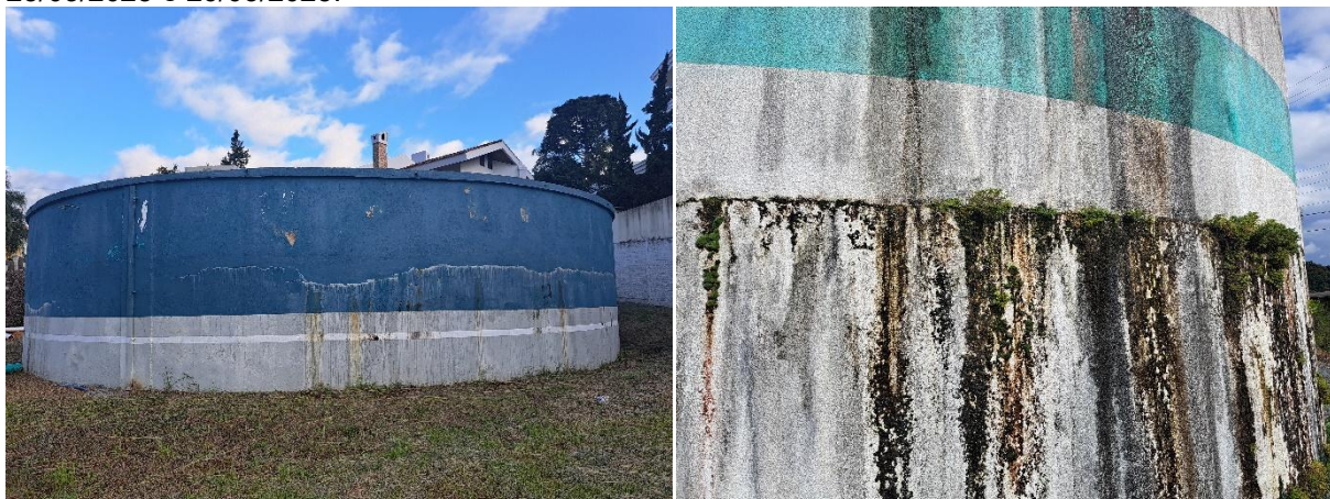
Figura 53: Reservatórios R1 (esquerda) e R12 (direita) em mau estado de conservação – entre 25/03/2025 e 26/03/2025.
