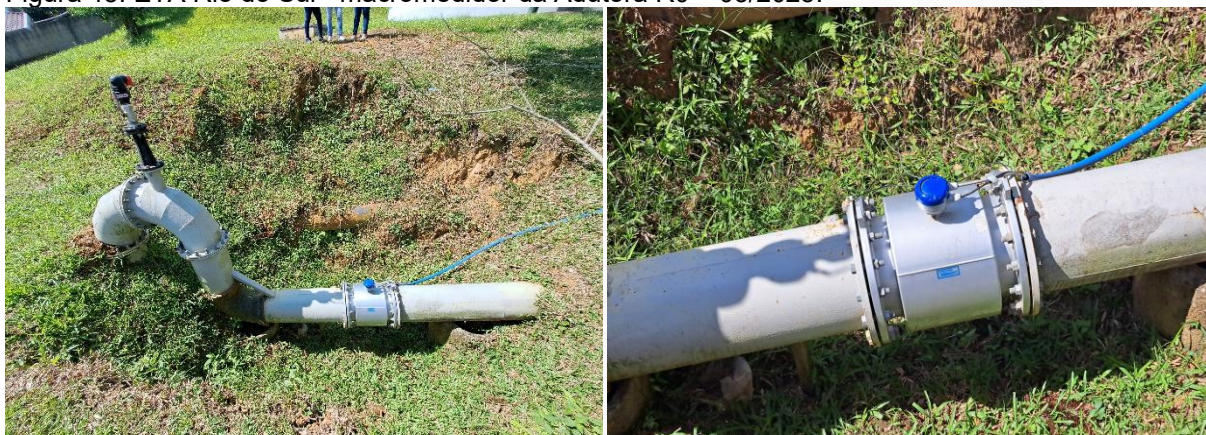
Figura 45: ETA Rio do Sul - macromedidor da Adutora R0 – 03/2025.
