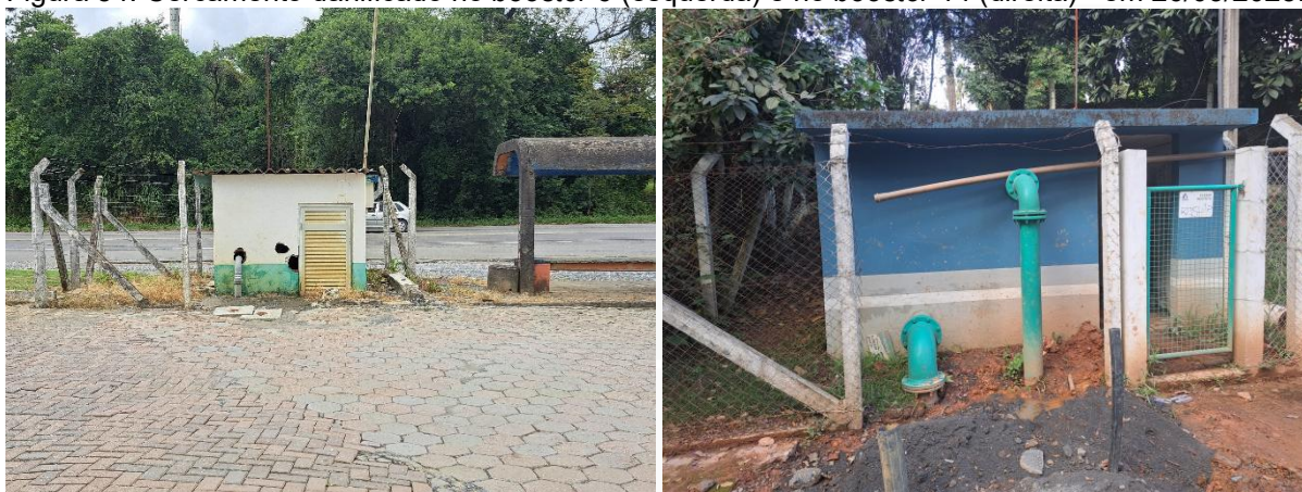
Figura 54: Cercamento danificado no booster 6 (esquerda) e no booster 14 (direita) - em 26/03/2025.
