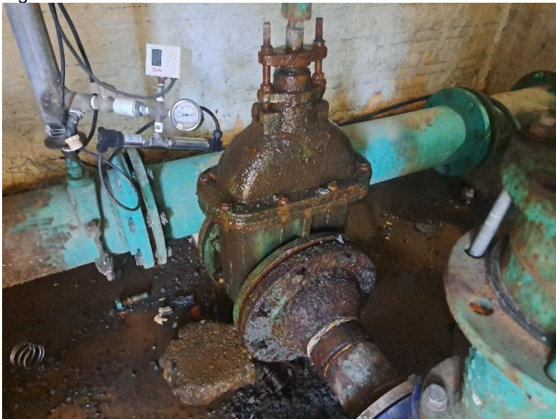
Figura 60: Vazamento em válvula do booster 14 – em 26/03/2025.
