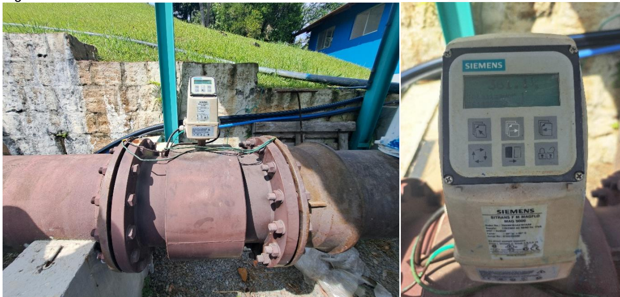
Figura 33: ETA RIO DO SUL - Macromedidor de entrada – 03/2025.
