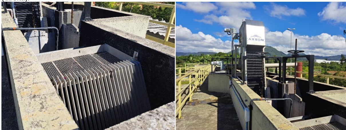
Figura 70: ETE Rio do Sul - Gradeamento manual grosseiro (esquerda) e peneiramento automático (direita).
