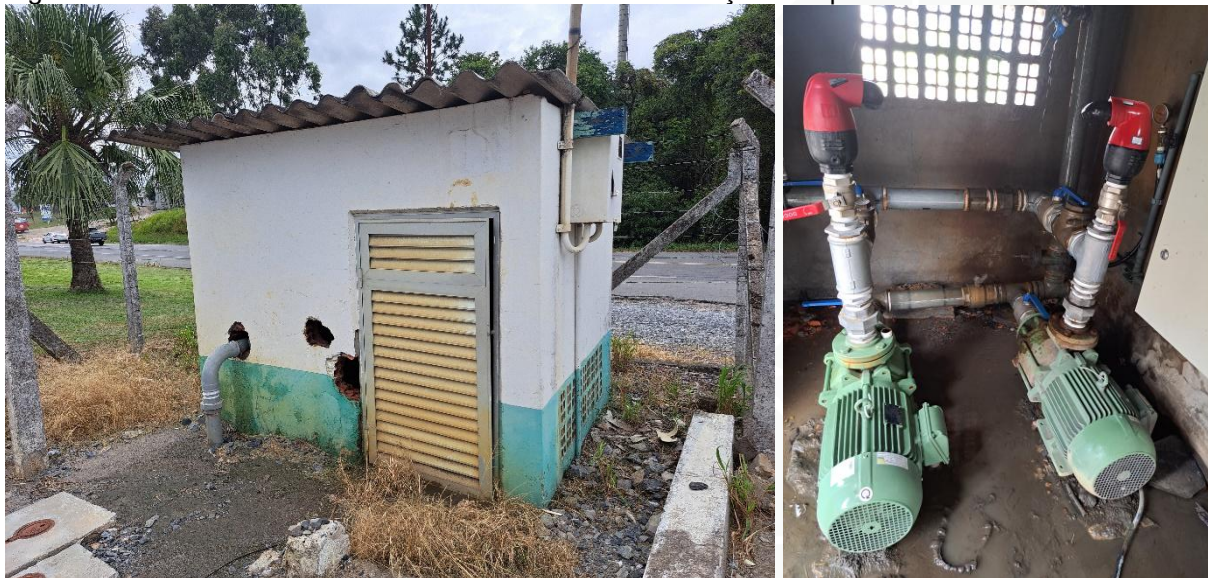
Figura 56: Booster 6 - Estrutura em mau estado de conservação e limpeza - em 26/03/2025.
