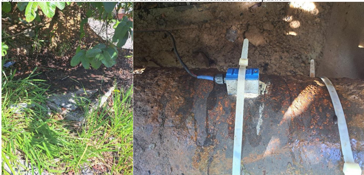
Figura 46: Macromedidor ultrassônico da adutora do R0 instalado na via pública.
