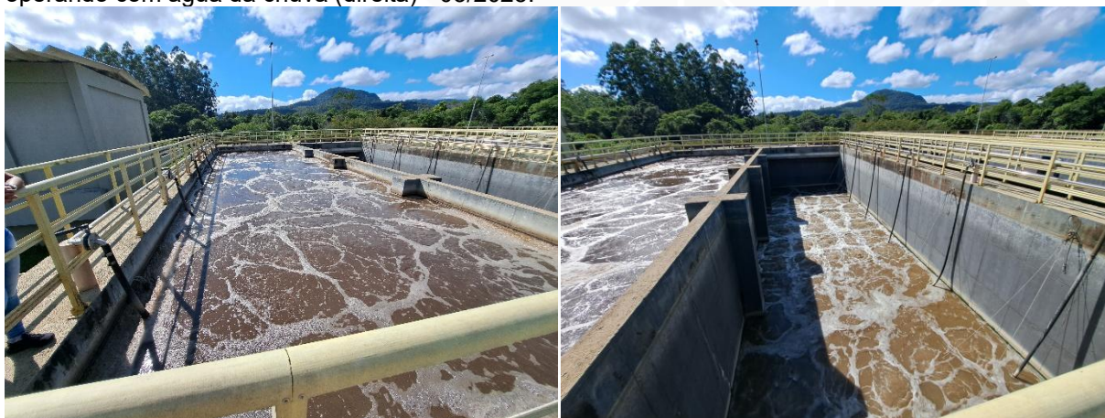
Figura 75: ETE Rio do Sul – tanque de aeração 01 em operação (esquerda) e tanque de aeração 02 operando com água da chuva (direita) - 03/2025.
