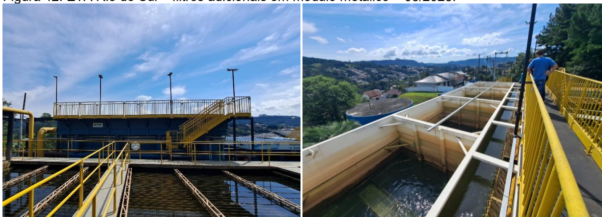
Figura 42: ETA Rio do Sul – filtros adicionais em módulo metálico – 03/2025.
