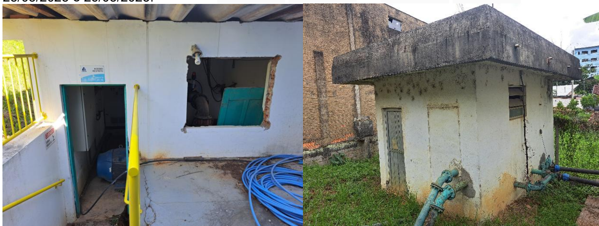
Figura 57: Má conservação das unidades de recalque – ERAT 03 (esquerda) e ERAT 16 (direita) entre 25/03/2025 e 26/03/2025.
