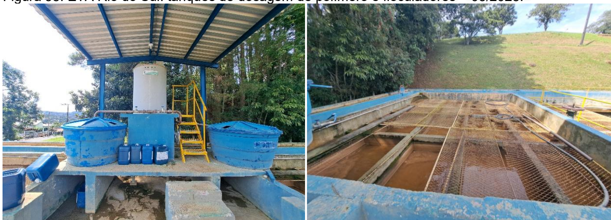
Figura 38: ETA Rio do Sul: tanques de dosagem de polímero e flocculadores – 03/2025.
