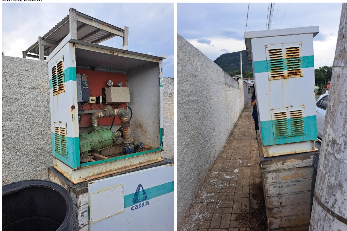
Figura 58: Booster 56 - Abrigo metálico danificado e base inclinada devido a recalque do solo - em 25/03/2025.
