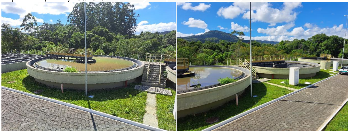
Figura 77: ETE Rio do Sul – decantador secundário em operação (esquerda) e decantadores inoperantes (direita) - 03/2025.
