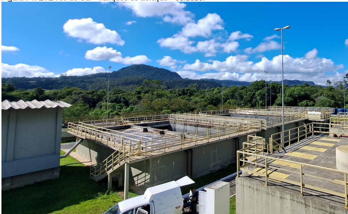
Figura 74: ETE Rio do Sul - Tanques de aeração - 03/2025.
