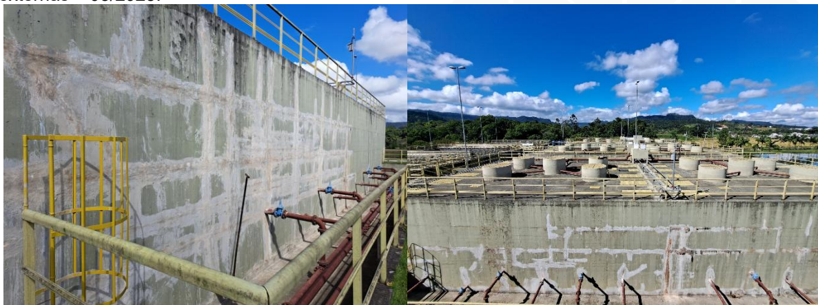
Figura 80: Estrutura dos reatores UASB, com presença de diversos reparos superficiais nas paredes externas – 03/2025.
