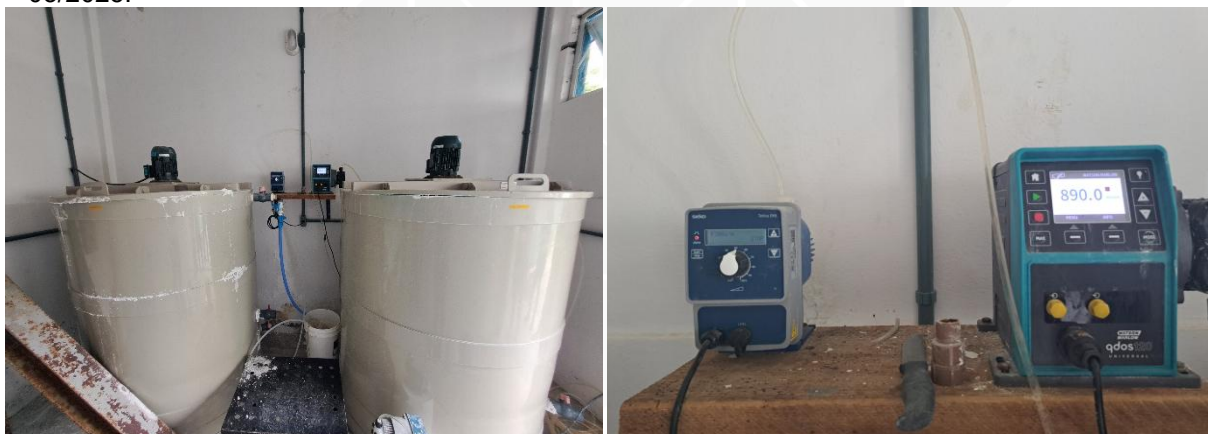
Figura 37: ETA – correção de pH - tanques de preparo e bombas dosadoras – ETA de concreto armado – 03/2025.
