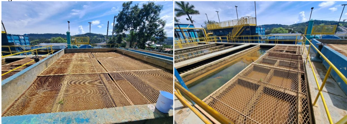
Figura 39: ETA Rio do Sul - flocculadores – 03/2025.
