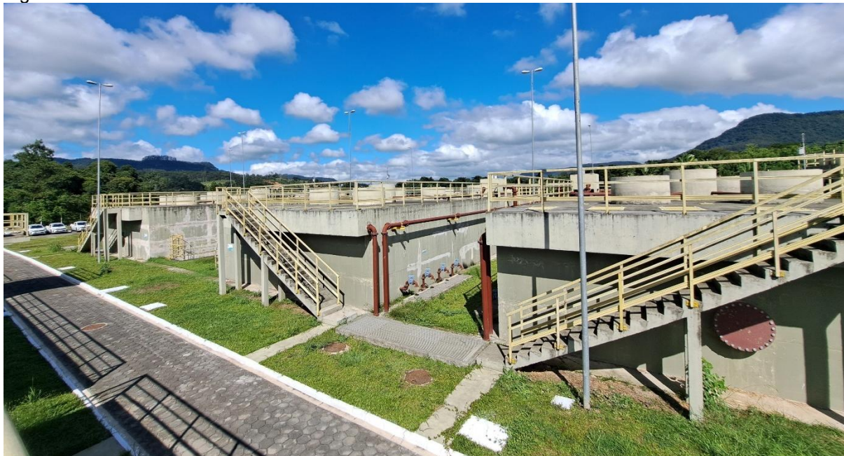
Figura 72: ETE Rio do Sul - Reatores UASB - 03/2025.
