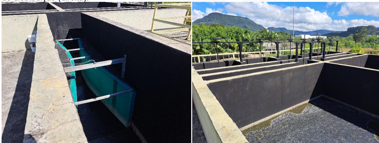
Figura 71: ETE Rio do Sul - Controle da vazão – Calha Parshall (esquerda) e caixa de gordura e canais de distribuição (direita).
