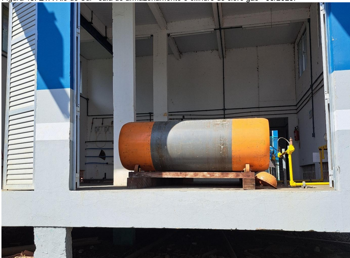
Figura 43: ETA Rio do Sul - sala de armazenamento e cilindro de cloro gás - 03/2025.
