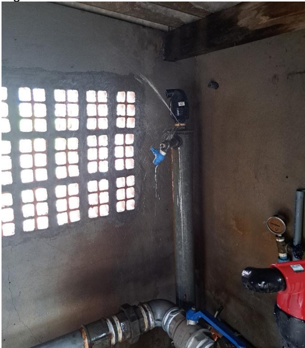
Figura 61: Vazamentos no booster 6 - em 25/03/2025.
